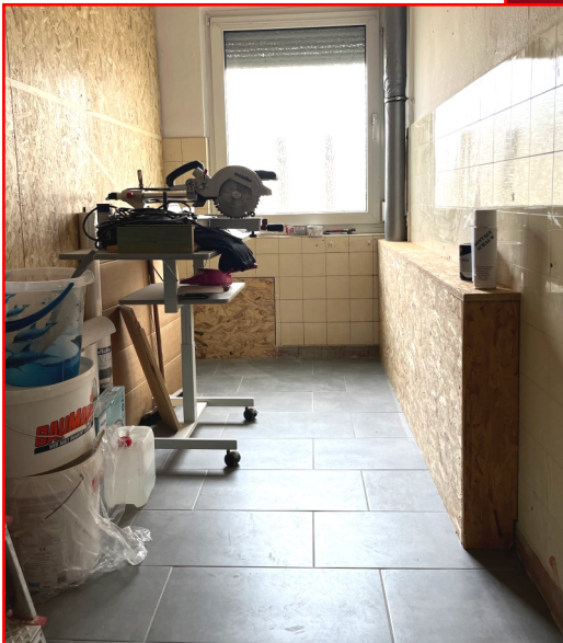
Das alte Bad - hier entsteht Abstellfläche für die neue Küche
